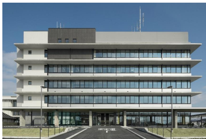
朝倉市役所 新庁舎
